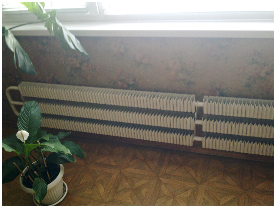
Seni radiatoriai Vilniaus Lazdynų mikrorajone esančiame sovietinės statybos daugiabutyje
