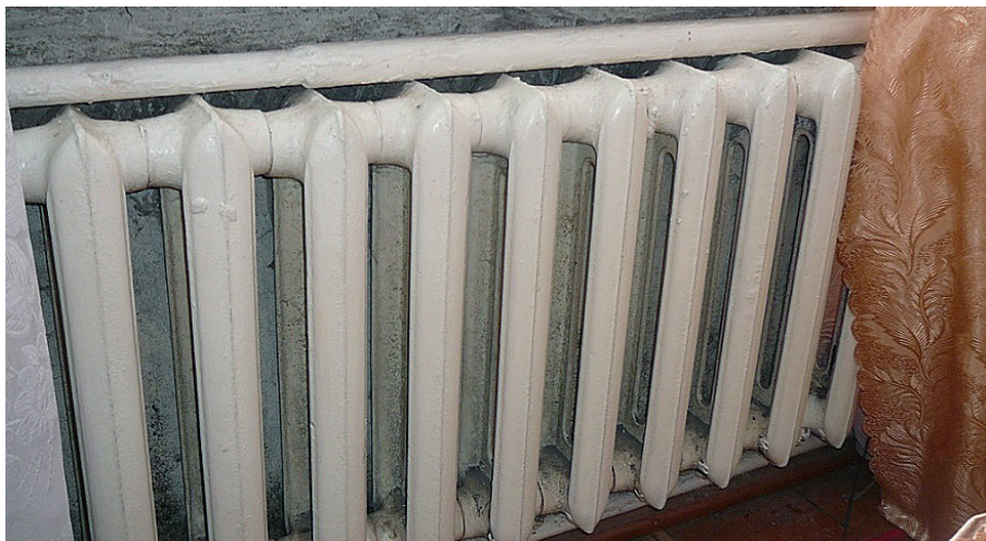
Apie 90 proc. sovietinės statybos daugiabučių namų yra įrengta vienvamzdė vidaus šildymo sistema, ir kasdienė šilumininkų praktika rodo, kad šios sistemos dažniausiai, deja, būna išbalansuotos, dėl to vieni butai peršildomi, kiti šąla
