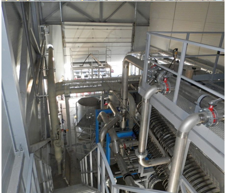
3 MW galios kondensacinio ekonomazerio statyba Panevėžio RK-1 katilinėje
