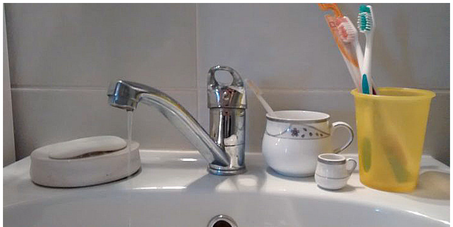
Kad iš čiaupo iškart tekėtų karštas vanduo, būtina vykdyti sistemoje cirkuliaciją. Šilumos sąnaudas karšto vandens cirkuliacijai reglamentuoja Valstybinė kainų ir energetikos kontrolės komisija
