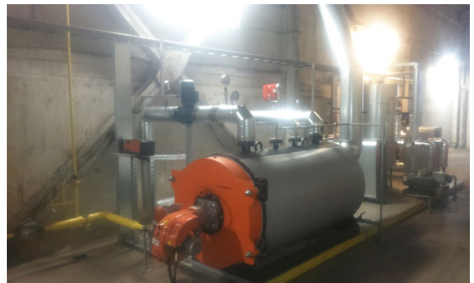
1 nuotrauka. Vandens šildymo katilas, vakuuminis deaeratorius ir šilumokaitis +8 000 lygyje
