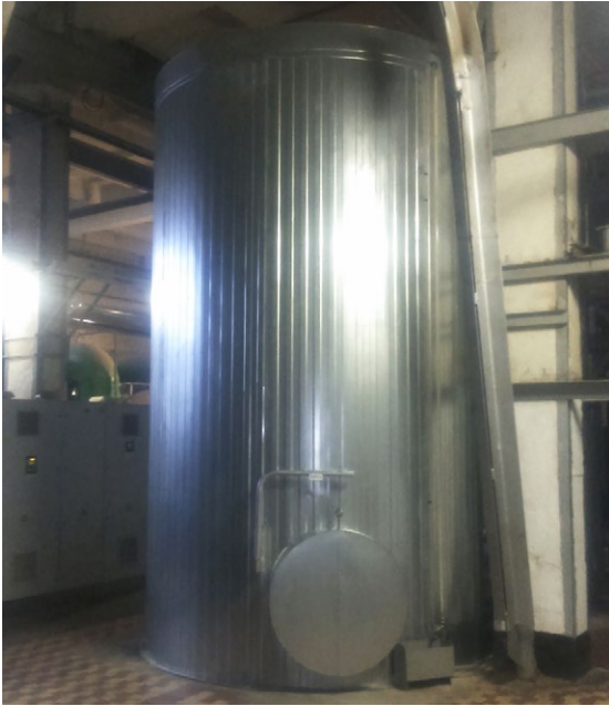
3 nuotrauka. Deaeroto vandens akumuliatorinė talpa +0 lygyje
