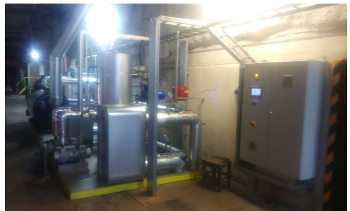
2 nuotrauka. Vakuuminis deaeratorius, šilumokaitis ir valdymo skydas +8 000 lygyje
