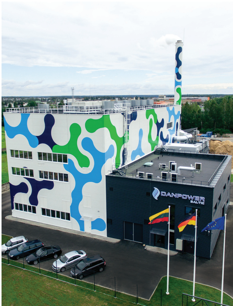
„Danpower Baltic“ biokgeneracinė elektrinė
