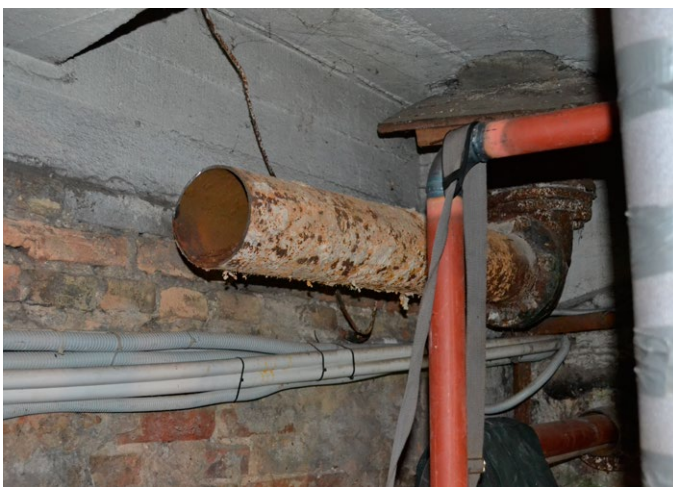
Senamiesčio daugiabučiuose vidaus šildymo sistemos buvo natūralios cirkuliacijos, todėl dabar vamzdinių skersmenys yra per dideli
