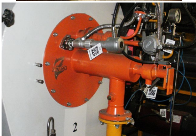
7 pav. Katilo PTVM-100 Nr. 4 degiklių išdėstymas ant priekinės sienos, vaizdas iš katilo kūryklos vidaus ir iš katilo priekio
