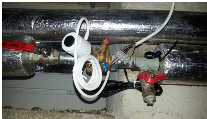
Vidaus šildymo sistemos balansavimo įranga su automatika
