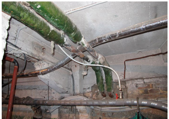
Senamiesčio daugiabučiuose vidaus šildymo sistemos buvo natūralios cirkuliacijos, todėl dabar vamzdinių skersmenys yra per dideli
