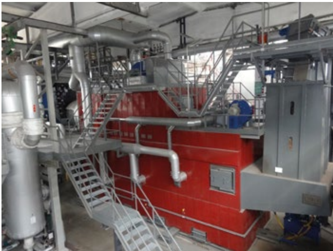
4 pav. Biokurą naudojančiąs garo katilai, įrengti UAB „Utenos šilumos tinklai“ ir UAB „Mažeikių šilumos tinklai“ (iš viso šilumos tiekimo įmonei 2015 metais buvo įrengta virš 30 biokatilų)
