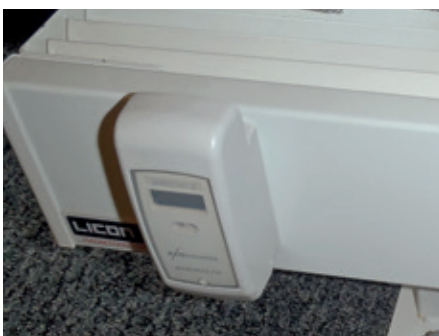
2. pav. Individuali šilumos apskaita šilumos kiekio dalikliais
