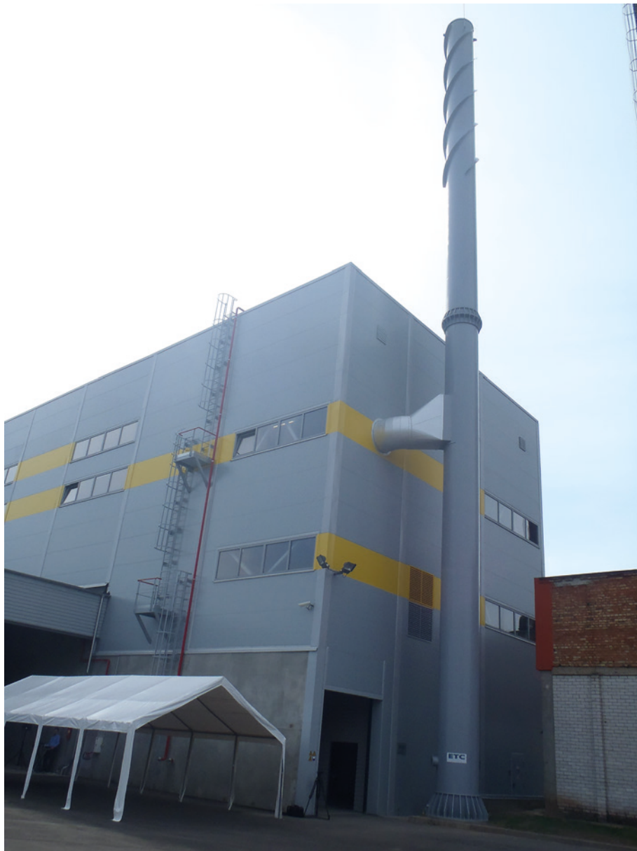
Šiomet rugpjūčio 27 d. AB „Panevėžio energija“ baigė modernizuoti Rokiškio miesto biokuro katilinę
