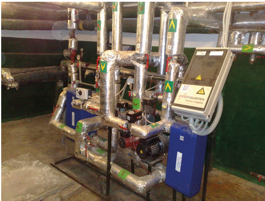
Automatinis, pagal lauko oro temperatūrą šilumos parametrus palaikantis, šilumos punktas
