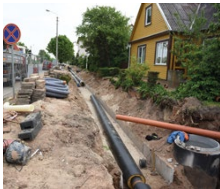
Šilumos trasų rekonstrukcijos Panevėžio, Kupiškio gatvėse
