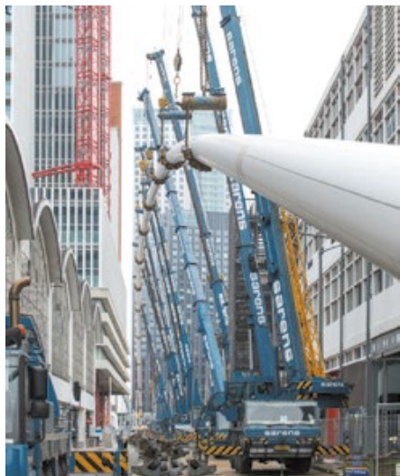
Įrengiamos naujos CŠT sistemos Roterdamo centre
